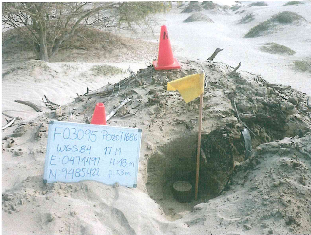
Fotografía N° 1. Identificación del pozo inactivo con código PERUPETRO T1686. Presenta casing sin brida ni válvula.
