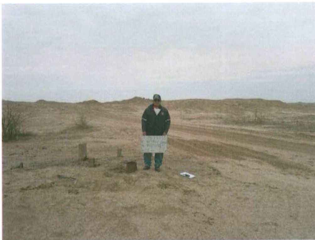
Fotografía N° 1. Identificación del pozo inactivo con código PERUPETRO T2553. Presenta casing sin válvulas que aseguren su hermetismo.
