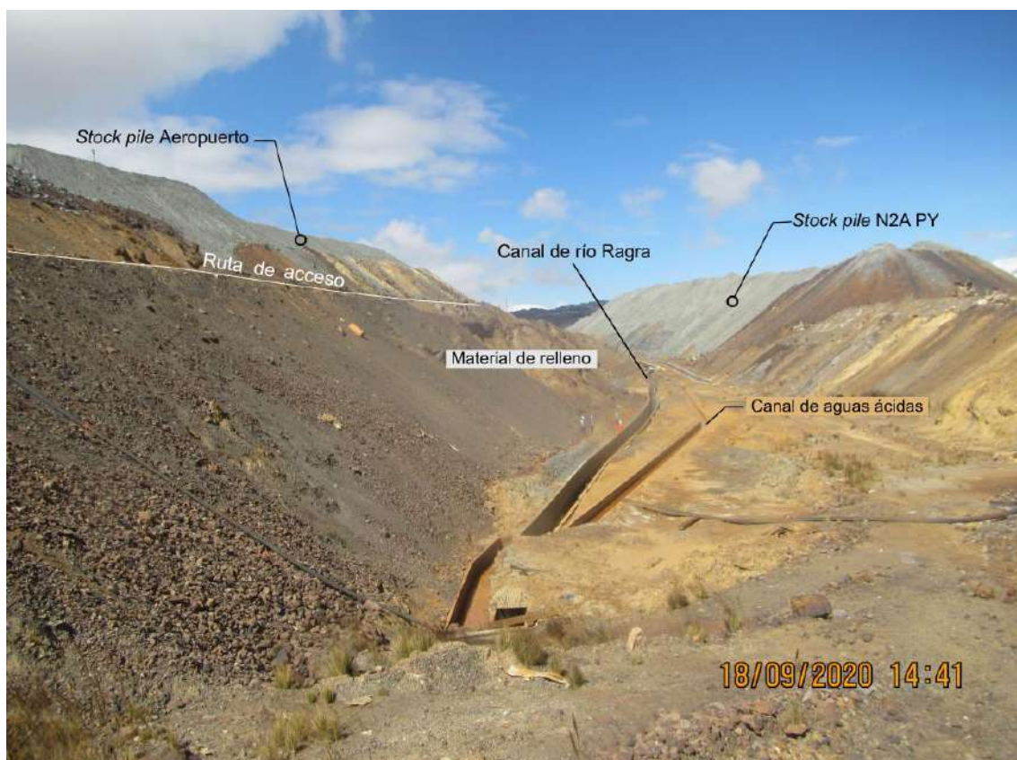
Figura 7.9. Ubicación de stock pile Aeropuerto y material de relleno con relación al canal del río Ragra
