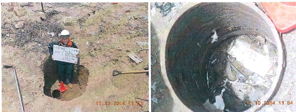
Fotografía N° 3. Se observa pozo abierto y expuesto al ambiente, sin accesorios que garanticen su hermetismo, presenta casing cortado y corroído y una mezcla heterogénea de agua y residuos sólidos en su interior
