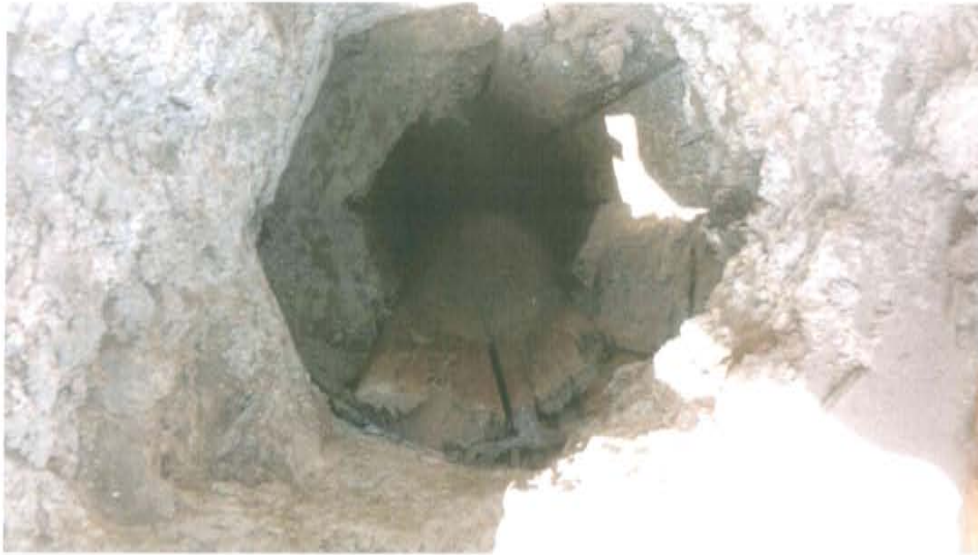
Fotografía N° 1. Pozo T_731, presenta conductora de madera de aproximadamente 20 pulgadas de diámetro.
