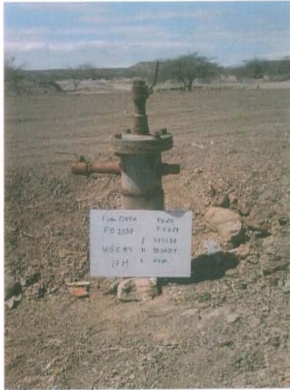
Fotografía N° 1. Pozo inactivo con código PERUPETRO T3329. Se observa casing a nivel de superficie, no presenta cabezal.
