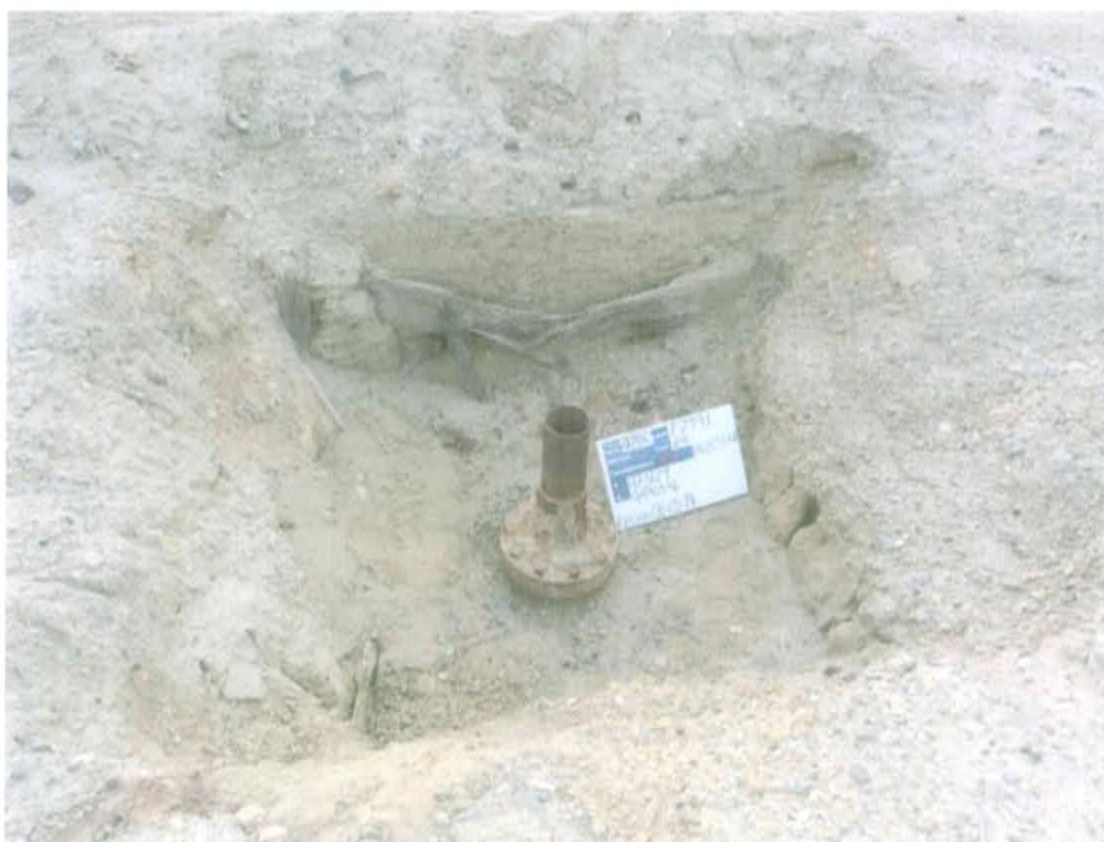
Fotografía N° 1. Identificación del pozo inactivo con código PERUPETRO T2991, en avanzado estado de corrosión, con brida y sin accesorios que aseguren su hermetismo.
