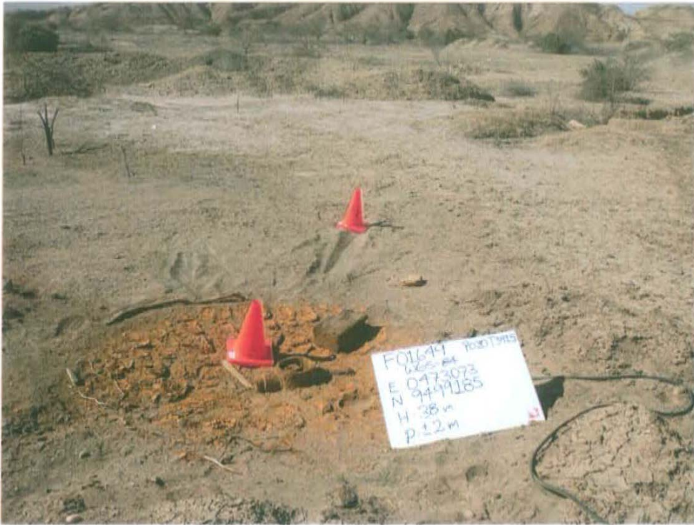
Fotografía N° 1. Pozo inactivo de la ficha F01649 que muestra casing de superficie a 0,08 m sobre el nivel del suelo, no se visualiza restos de la cantina.
