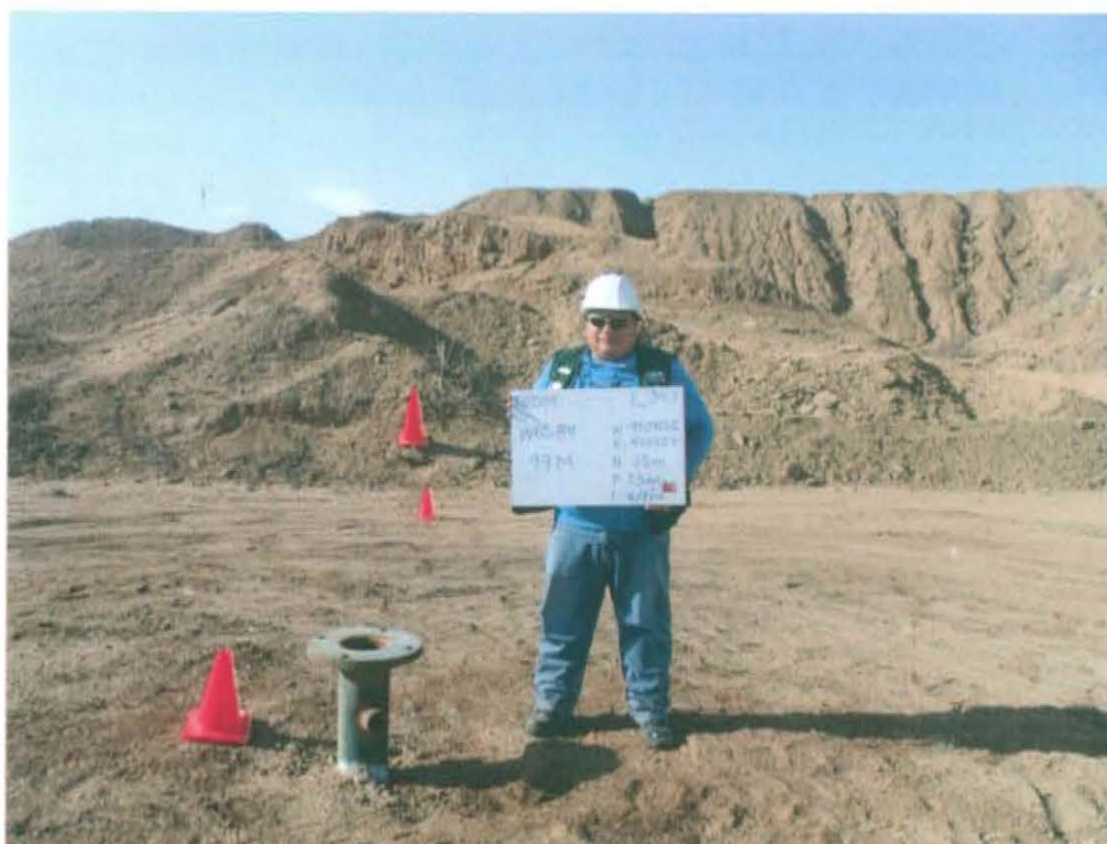
Fotografía N° 1. El cabezal del pozo sobresale 0,43 m de la superficie del suelo y se encuentra abierto al ambiente.
