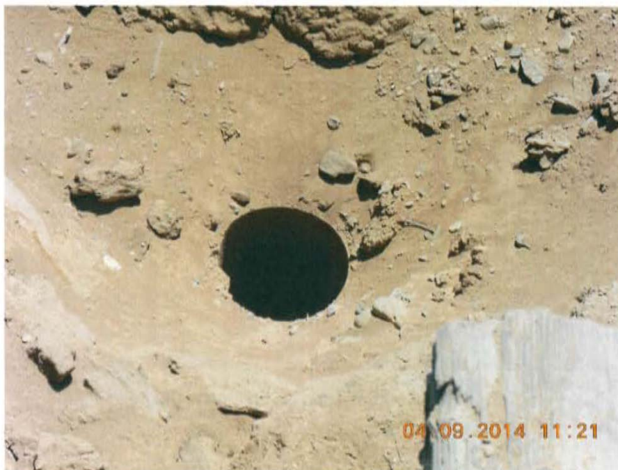
Fotografía N° 4. En el interior del hoyo se observa un casing de producción de 8·plg de diámetro.
