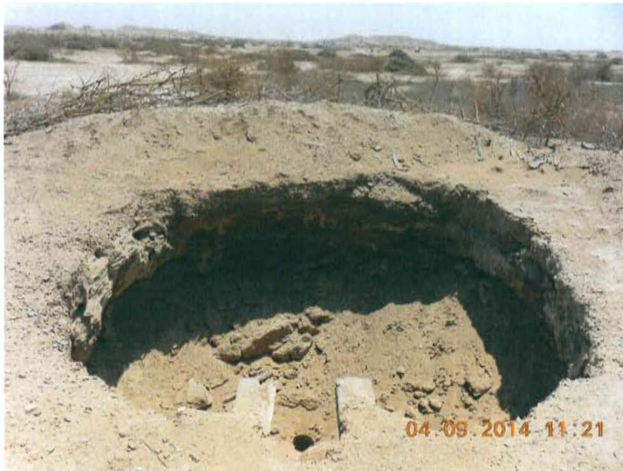
Fotografía N° 3. Se observa un hoyo 3,6 m x 4 m x 2 m de profundidad con suelo y residuos con presencia de hidrocarburos.
