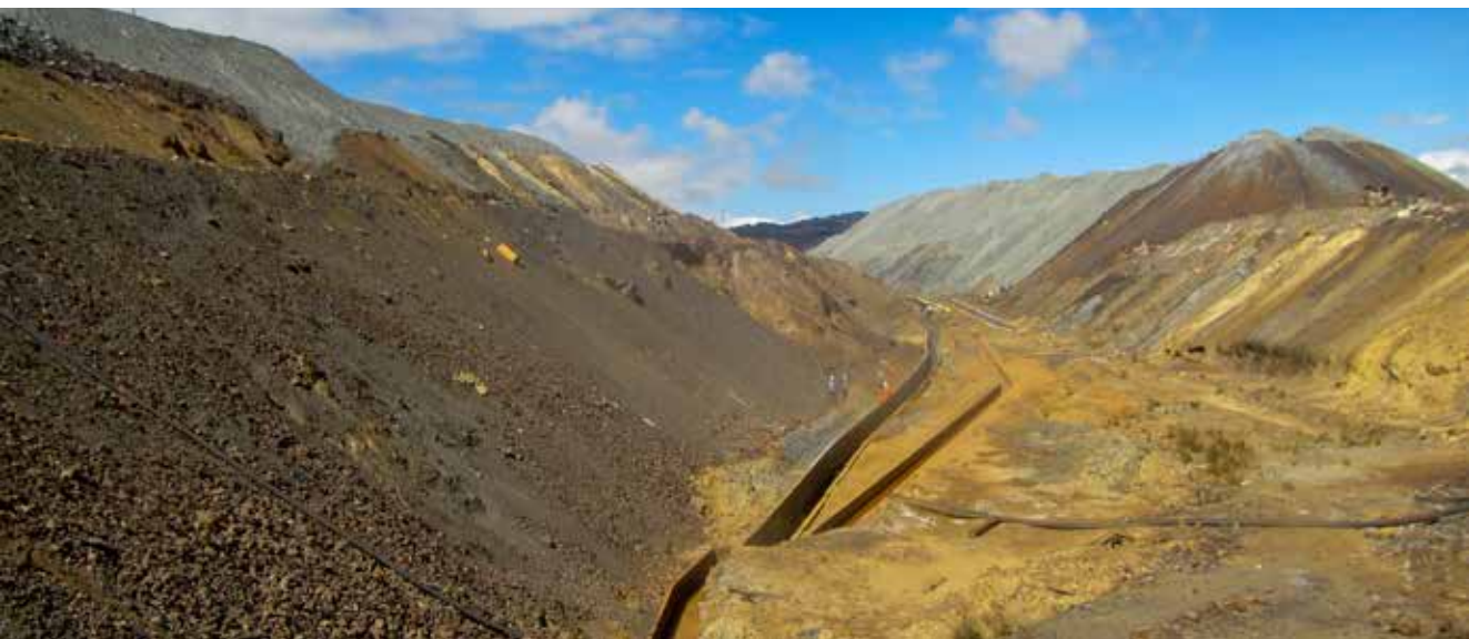
Figura 11. Ubicación de stock piles Aeropuerto con presencias de cárcavas que indican escorrentías en dirección al canal del río Ragra, así como el ingreso a este canal de material de relleno
