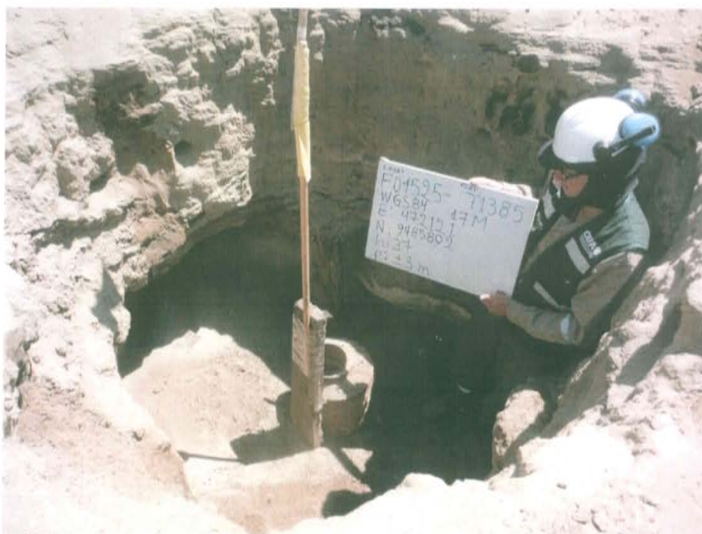
Fotografía N° 1. Identificación del pozo inactivo con código PERUPETRO T1385. Presenta casing sin válvulas que aseguren su hermetismo.
