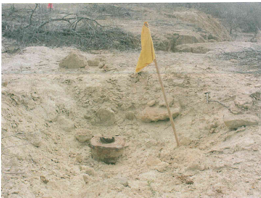
Fotografía N° 2. El pozo A9097 se encuentra dentro de un hoyo de sección Circular y a una profundidad de 0,4m en relación a la superficie del terraplén.
