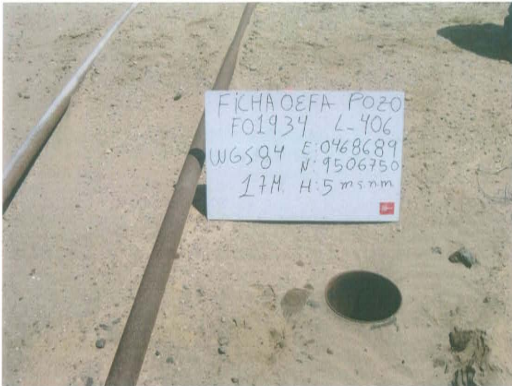
Fotografía N° 1. Identificación del pozo inactivo con código PERUPETRO L_406. Presenta casing abierto al medio ambiente.
