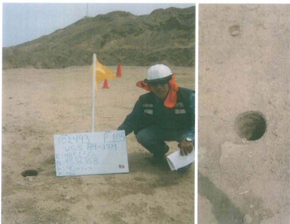
Fotografía N° 1. Identificación del pozo inactivo con código PERUPETRO P_105. Presenta casing corroído a nivel superficial, sin dispositivos de cierre por lo que se considera abierto y expuesto a la intemperie.
