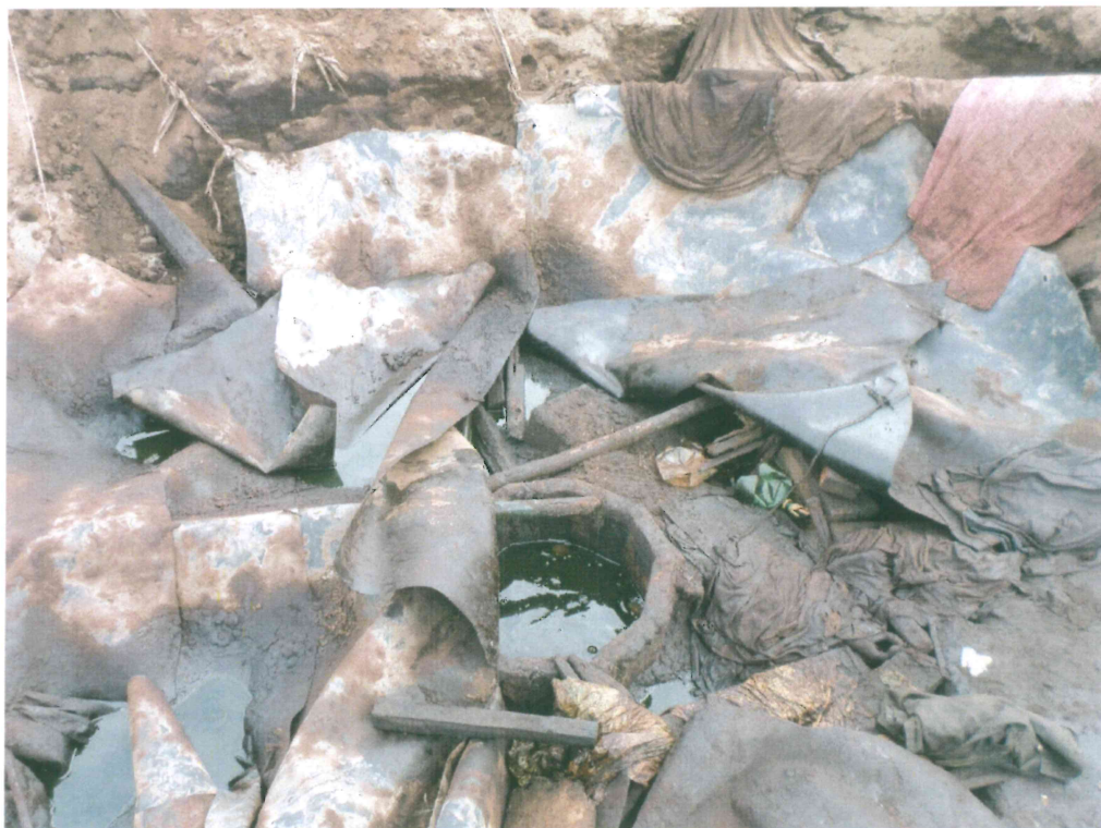
Fotografía N° 2. Vista del pozo T_975, se observa el casing abierto al ambiente y con fluidos en su interior.
