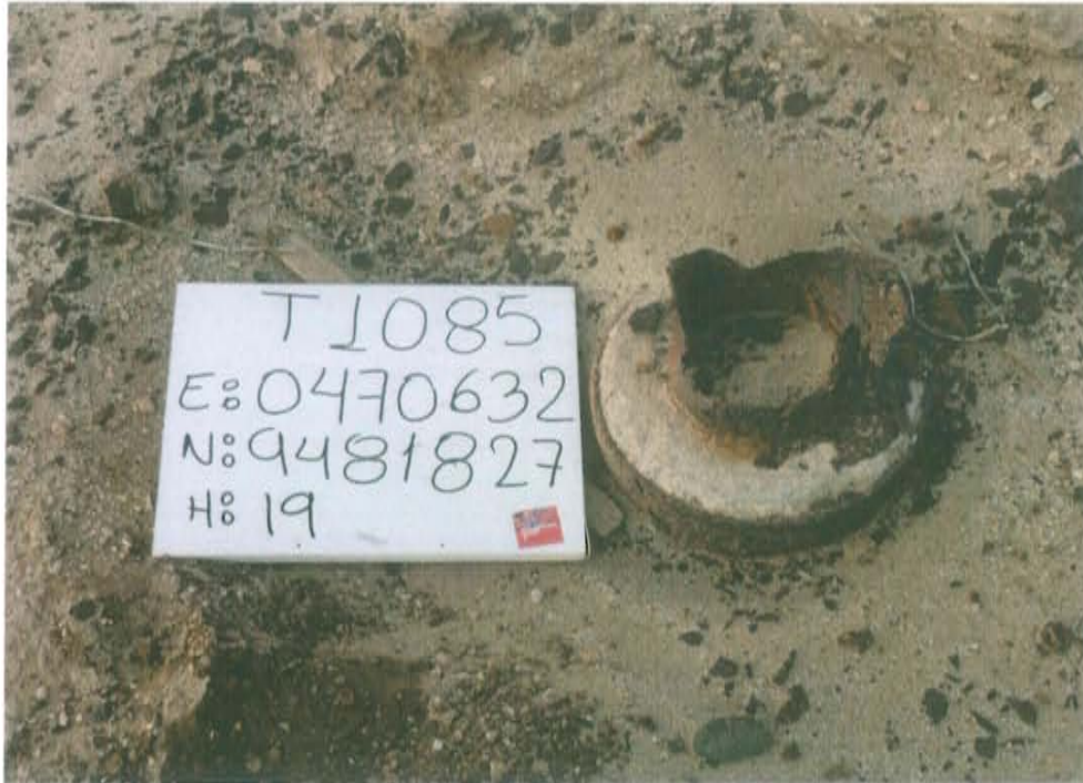
Fotografía N° 1. Pozo T1085 sin cabezal, con casing cementado y tubo interior en estado avanzado de corrosión y con acumulación de tierra en su interior.
