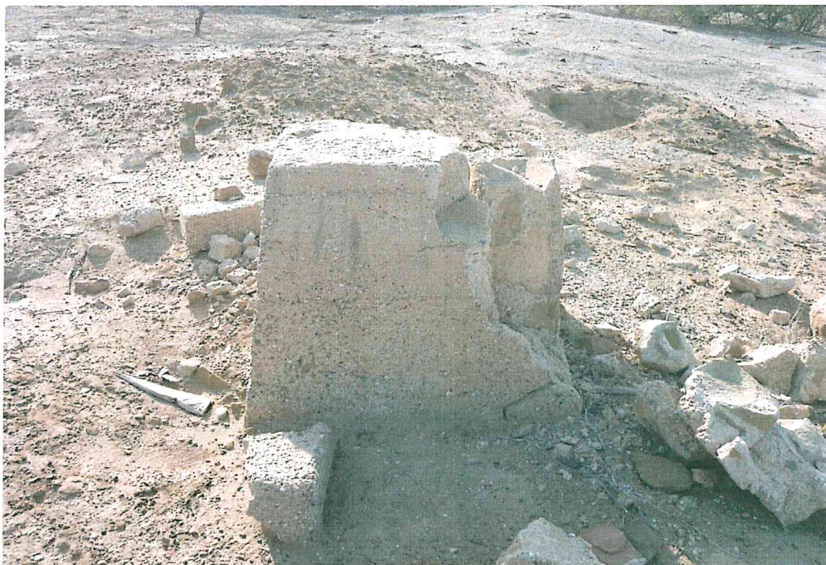
Fotografía N° 3. Se visualizó estructuras de concretos en zonas alrededor del área visitada.
