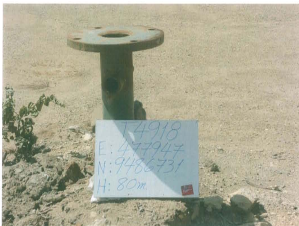
Fotografía N° 1. Pozo petrolero inactivo en terreno habilitado tipo terraplén con acceso vial directo, el pozo posee cabezal que sobresale 0,67 m sobre nivel del suelo, compuesto por una brida de 6 pulgadas unida al casing.
