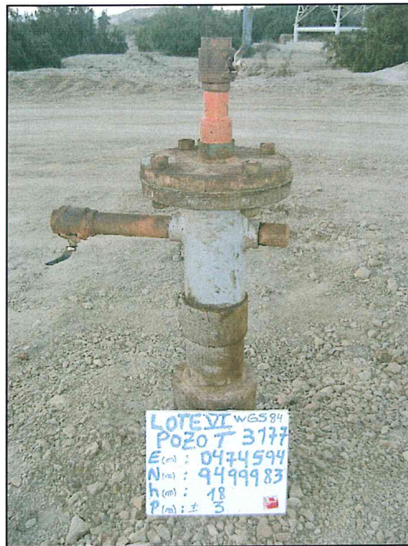
Fotografía N° 1. Se observa el Pozo T3177 con cabezal, brida y válvulas concéntricas y laterales sobresalientes sobre el nivel del suelo.
