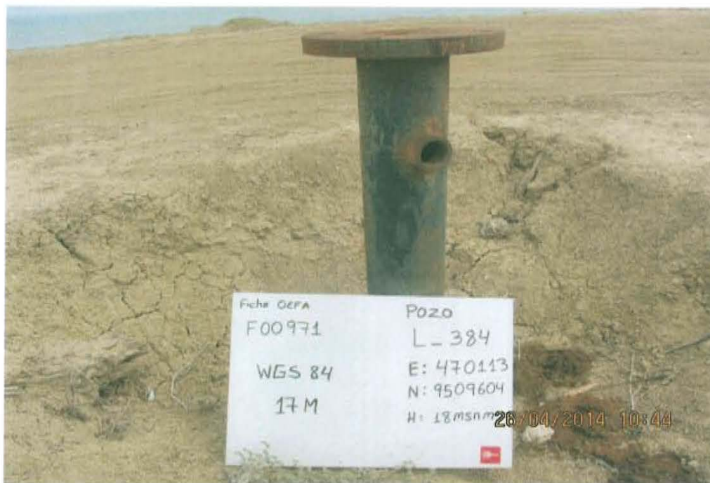
Fotografía N° 1. Se observa cabezal del pozo que sobresale 1 m de la superficie y se encuentra abierto al ambiente.
