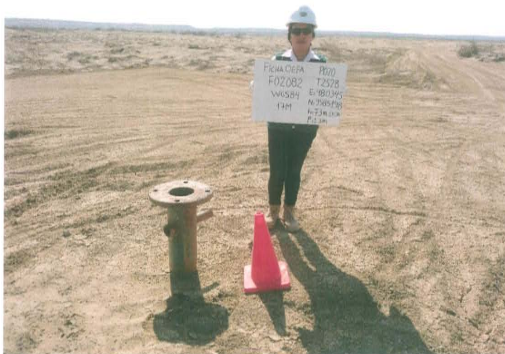
Fotografía N° 1. Identificación del pozo inactivo con código PERUPETRO T2528. Presenta casing con tapa de brida adaptadora con tubería lateral y sin válvulas que aseguren su hermetismo.
