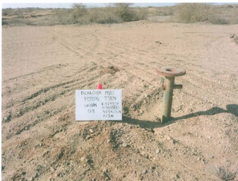
Fotografía N° 1. Identificación del pozo inactivo con código PERUPETRO T3104. Presenta casing con tapa de brida adaptadora y tubería lateral, expuesta a la intemperie.
