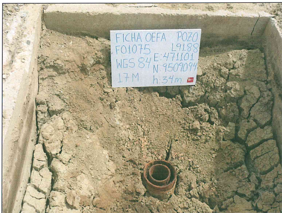
Fotografía N° 1. Vista del Pozo L9188, casing de 7 plg. de diámetro el cual se visualiza 0,25 m sobre el suelo dentro de la cantina; asimismo, se observa que el pozo no posee cabezal ni válvulas de cierre y se encuentra abierto al ambiente.
