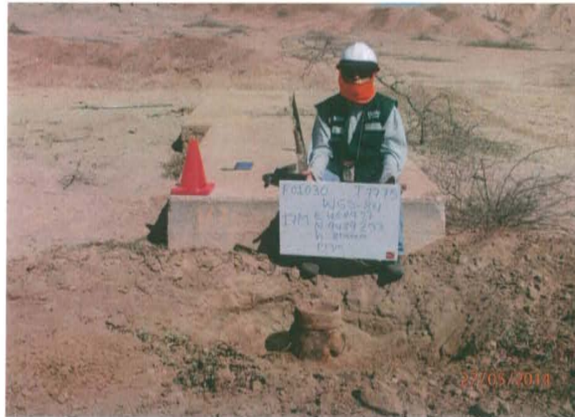
Fotografía N° 1. Pozo inactivo con casing corroído que sobresale 0,1 m sobre la superficie del suelo.
