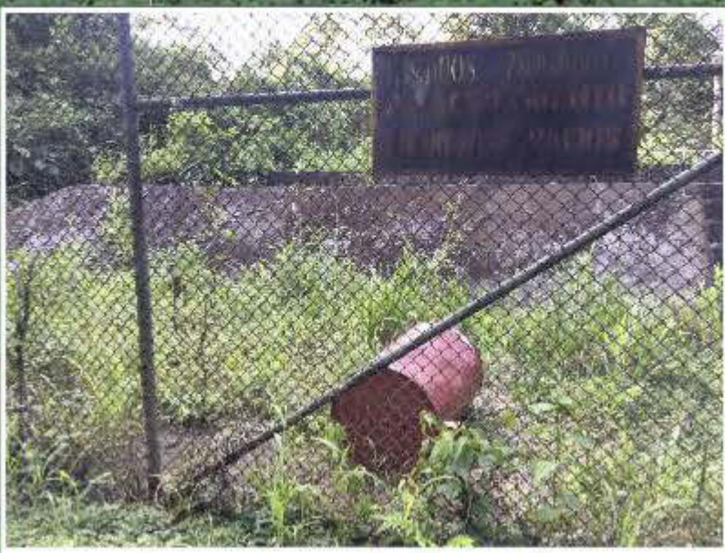
Almacén de residuos peligrosos
