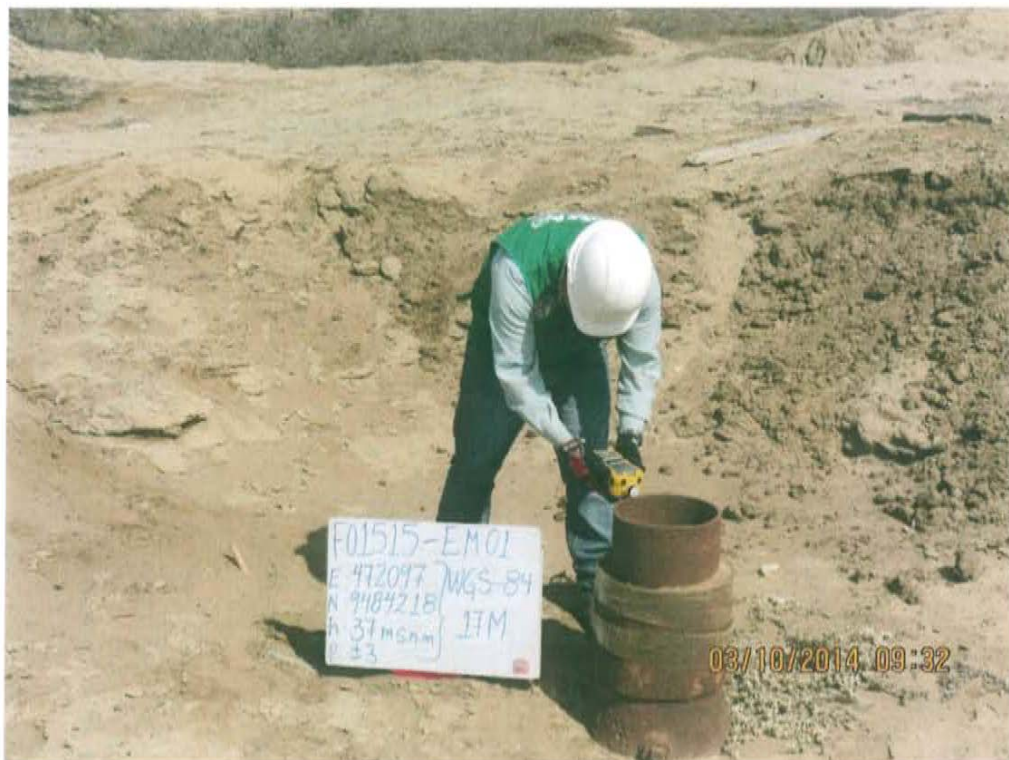
Fotografía N° 4. Medición en el punto F01515-EM01, ubicado en la fuente de emisión en boca del Pozo T1628.
