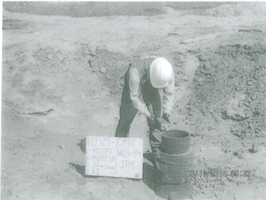
Fotografía N° 1. Medición en el punto F01515-EM01, ubicado en la boca del pozo.
