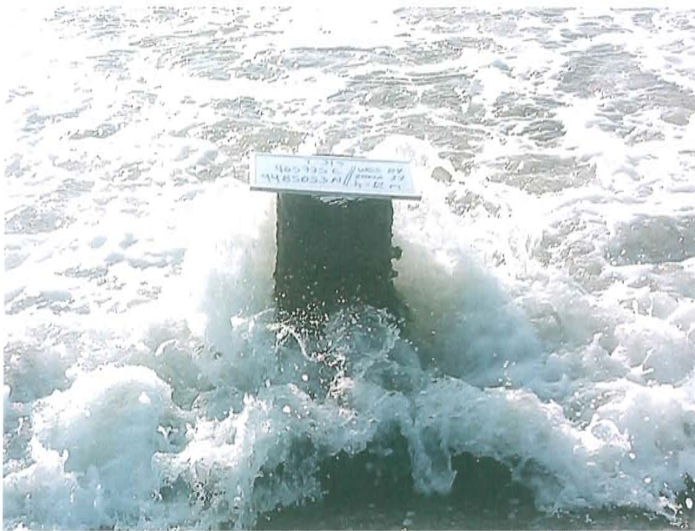
Fotografía N° 1. Identificación del pozo inactivo con código PERUPETRO T_315. Presenta casing sin elementos de cierre.
