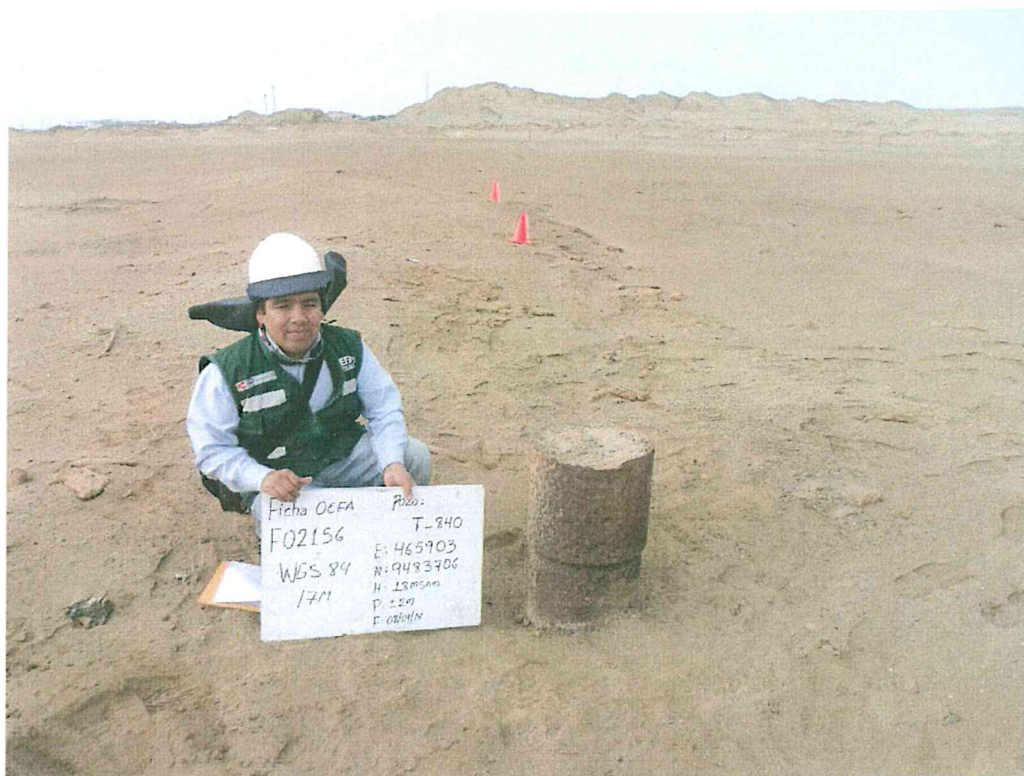
Fotografía N° 1. Se observa casing corroído que sobresale 0,5 m del nivel de la superficie de suelo.
