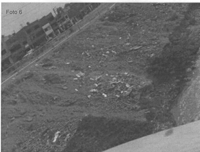
Fotografía N° 6. Evidencia de arrojó de residuos sólidos en las partes bajas y laterales del Puente Las Lomas, en el punto georeferenciado N° 1, del Cuadro N° 3. Coordenadas UTM WGS 84 (18L 0283193E 8669642N)
