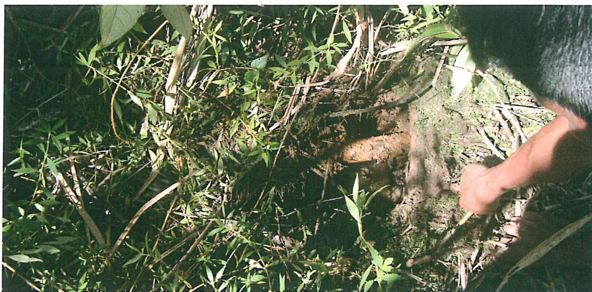
Fotografía N° 2. Vista en los alrededores del pozo QMC_50_43_1, en donde se observó una tubería acoplada a un codo de 1 plg aproximadamente de diámetro, en el interior de una canaleta con agua posiblemente de origen pluvial que discurre hasta la quebrada.
