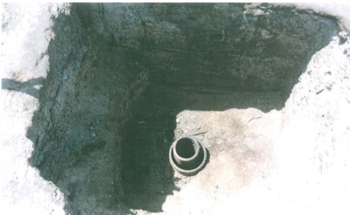
Fotografía N° 01.- Pozo con código PERUPETRO T2525 con Ficha OEFA F01238, se observa el casing con una tubería ambas corroídas sin cabezal o algún elemento de cierre por lo que encuentran abiertos al ambiente.
