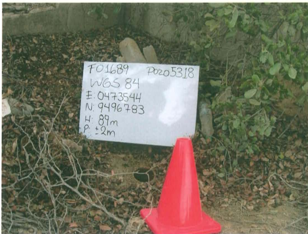
Fotografía N° 1. Identificación del pozo inactivo con código PERUPETRO T5318. Presenta casing sin válvulas que aseguren su hermetismo.
