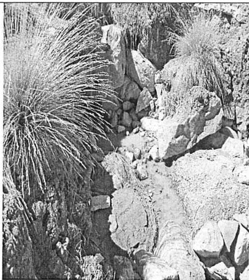
Punto georeferenciado P-5, descarga de efluente con sedimentos.
