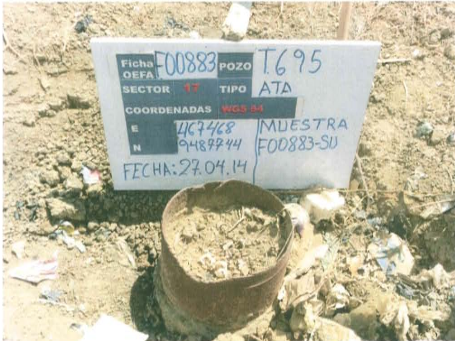
Fotografía N° 1. Pozo T_695, presenta casing cortado y abierto con arena en su interior.
