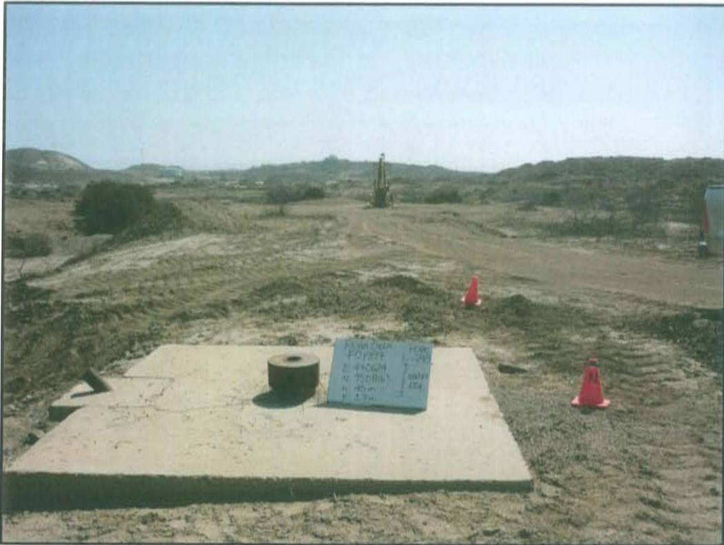
Fotografía N° 1. Pozo L_248 ubicado en base de concreto, a 70 m de pozo L_358, que se encuentra en estado activo.
