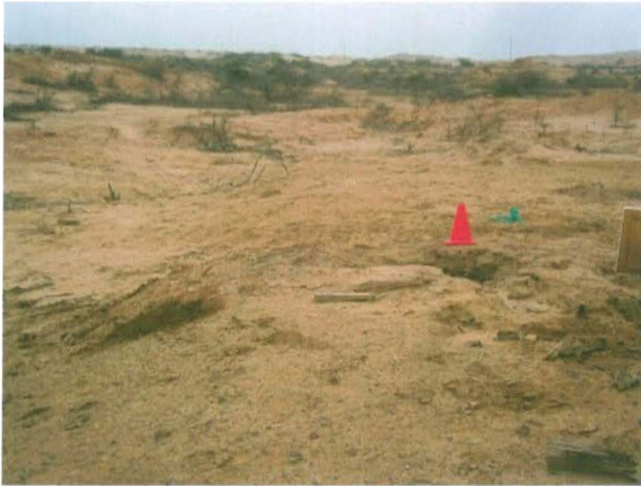
Fotografía N° 1. Ubicación del pozo inactivo en una hoyo, con casing expuesto al ambiente.
