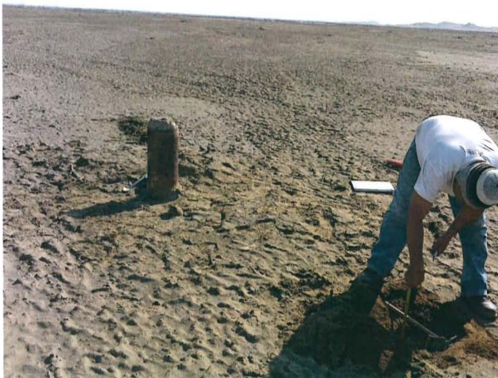
Fotografía N° 3. Se observa que existe suelo impregnado con hidrocarburo en los alrededores al pozo.
