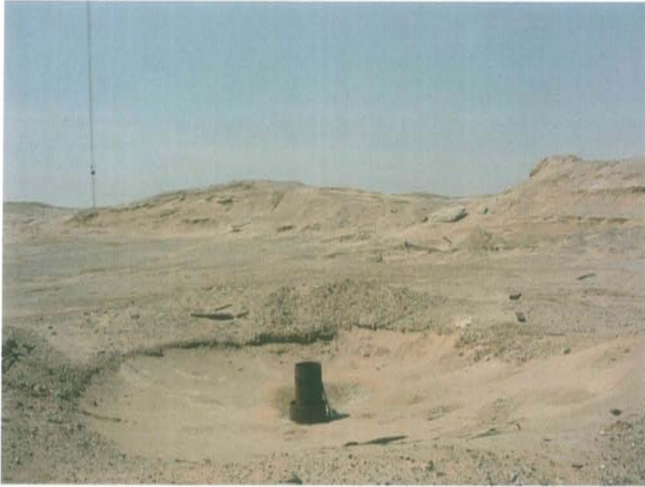
Fotografía N° 1. Vista panorámica del pozo inactivo ubicado en un terreno no habilitado con casing expuesto al ambiente.
