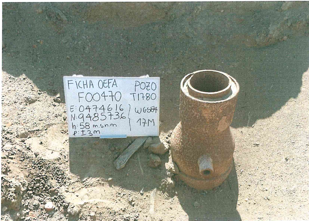
Fotografía N° 1. Pozo inactivo con código PERUPETRO T1780 que abierto y expuesto al ambiente.
