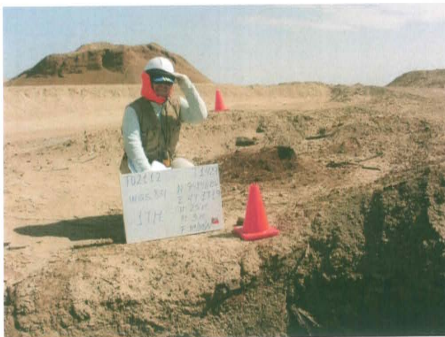
Fotografía N° 2. El pozo T1427 no está cercado ni señalizado, no presenta afloramientos solo se observa montículos de suelo con hidrocarburos en su alrededor.
