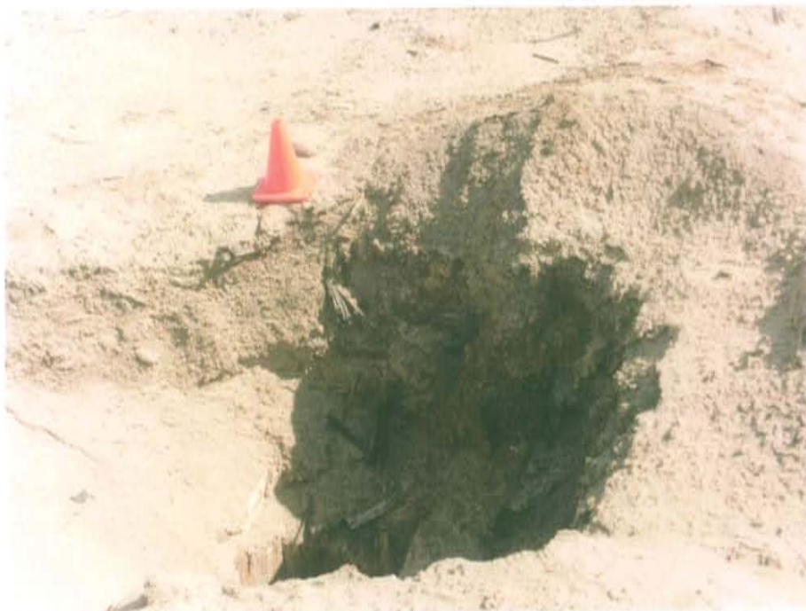
Fotografía N° 1. Pozo T1427 dentro de un hoyo de sección circular a 1,2 m de profundidad, con conductora de madera rodeando las paredes del pozo de 21 pulgadas de diámetro.
