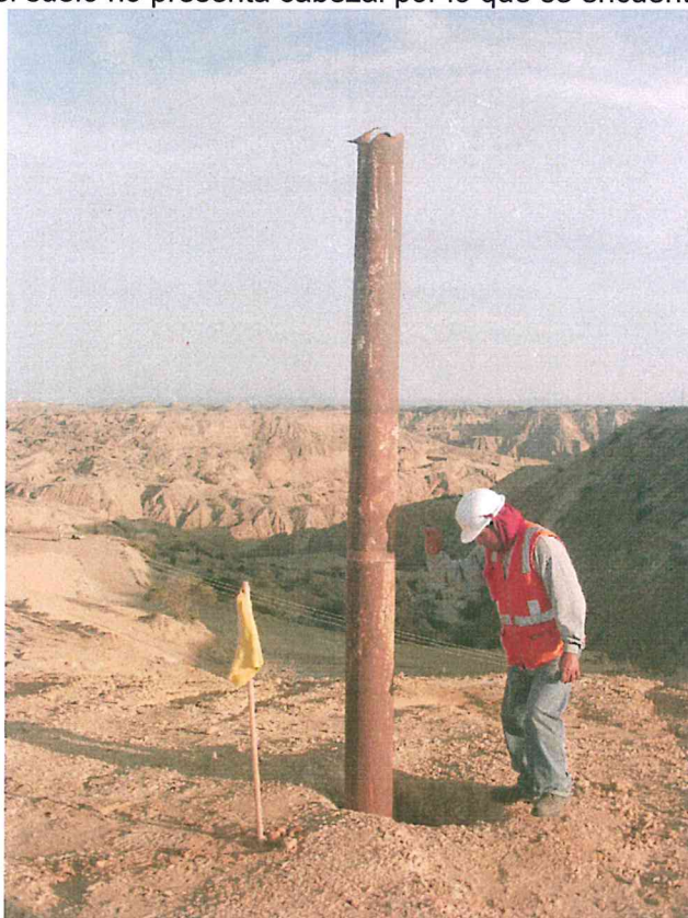
Fotografía N° 2. Pozo A_541 presenta movimiento al simple contacto.
