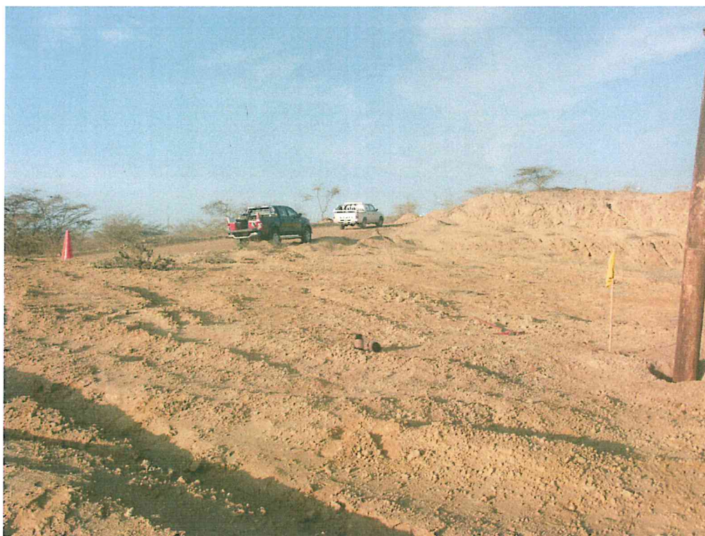
Fotografía N° 3. Pozo ubicado en una zona sin terraplén ni acceso vehicular directo, ya que cuenta con la vía afirmada a 10m. de distancia.
