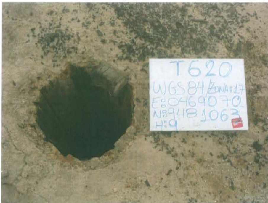
Fotografía N° 1. Pozo inactivo T_620, presenta conductora de madera abierta al ras del suelo.
