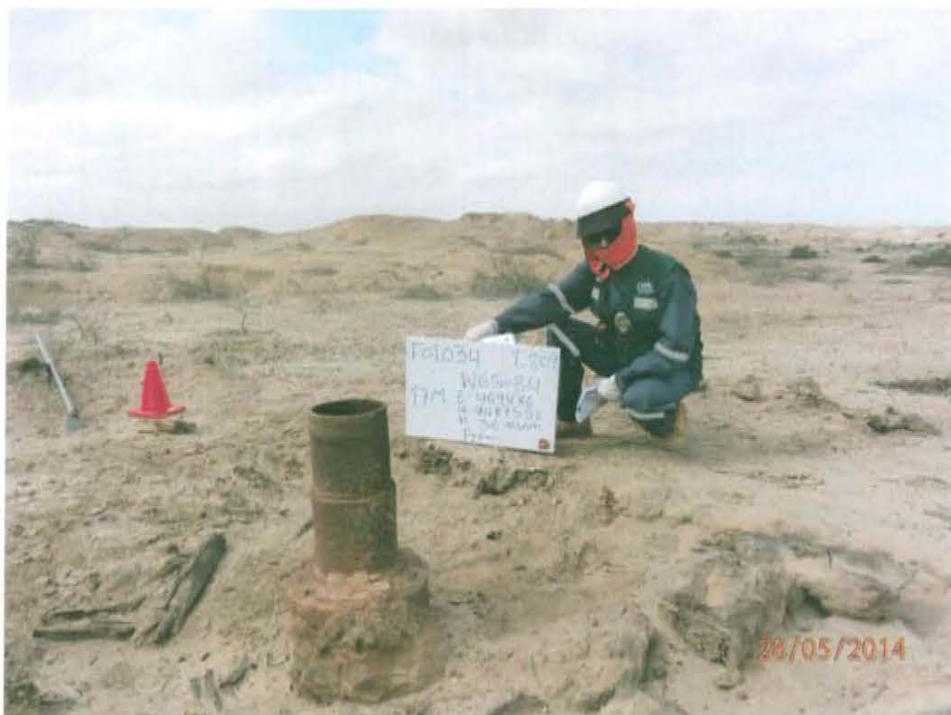
Fotografía N° 2. Coordenadas de ubicación del pozo T_809.
