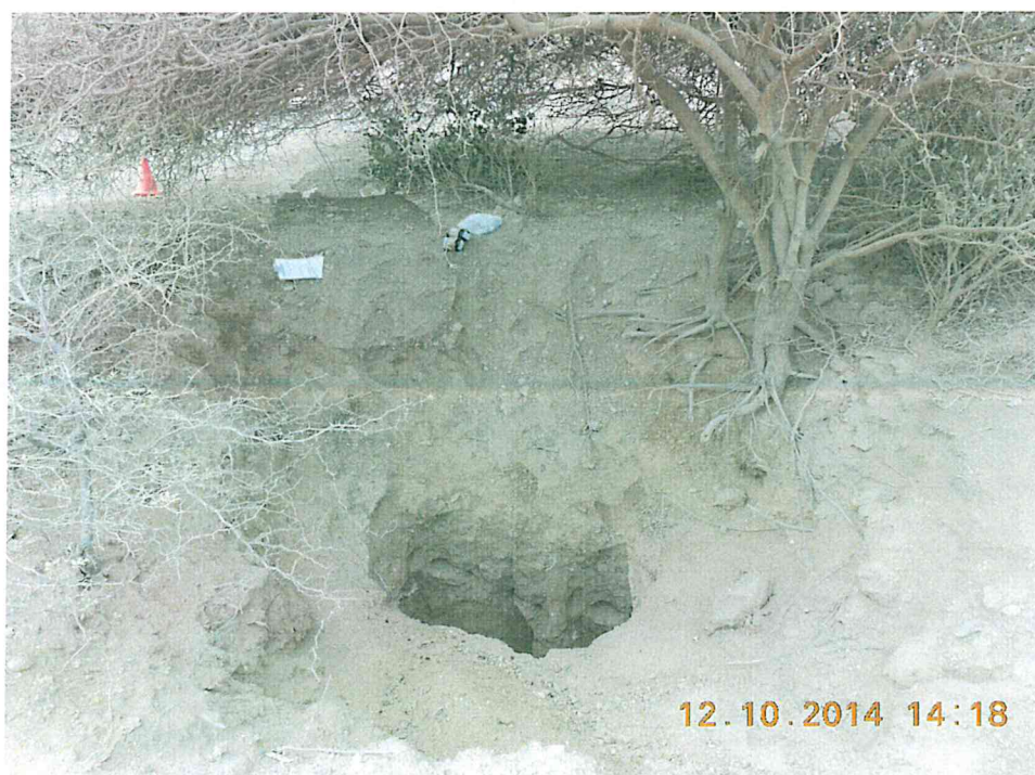
Fotografía N° 2. Debajo de un árbol de Vichayo se encontró un hoyo de 2,5 m de profundidad donde se encuentra enterrado el pozo, al encontrarse indicios de suelo con presencia de hidrocarburos en su interior.
