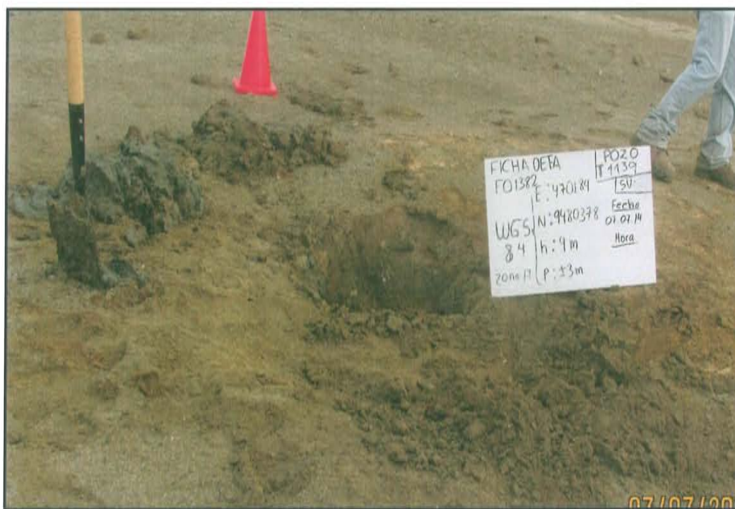
Fotografía N° 2. Pozo con código PERUPETRO T1139; con casing de 6 plg a nivel de la superficie del suelo.
