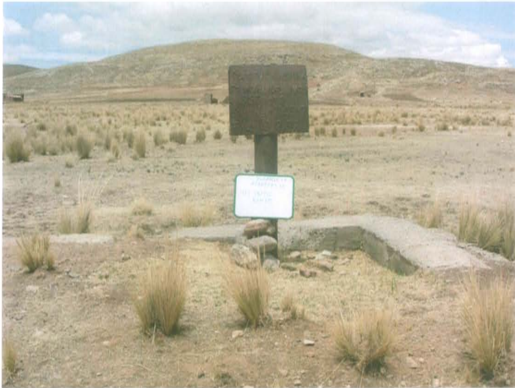
Fotografía N° 1. Pozo con código PERUPETRO YPA_S4_38_1 en el cual se observa el letrero de abandono, además se observa restos de concreto que posiblemente correspondan a una cantina.
