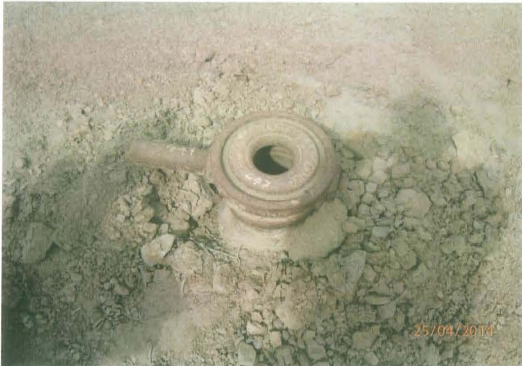
Fotografía N° 1. Vista donde se observa el pozo inactivo con el casing abierto a nivel del Suelo en estado de corrosión, sin elementos de cierre que garanticen su hermeticidad.
