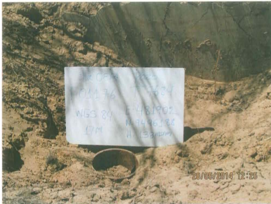
Fotografía N° 1. Pozo inactivo con código PERUPETRO T7684, se observa el casing (tubería de revestimiento) a nivel del suelo con presencia de tierra en su interior
