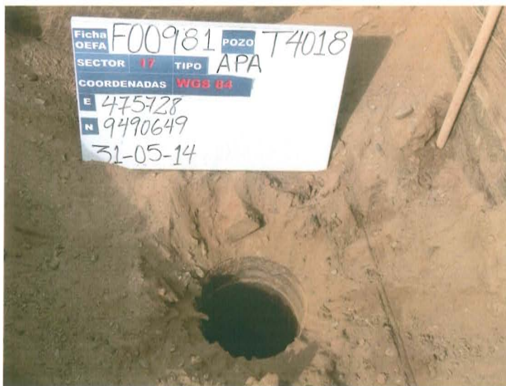
Fotografía N° 1. Identificación del pozo inactivo con código PERUPETRO T4018, con casing abierto a nivel del suelo, sin plancha de metal sobre el casing, ni cerco, ni señalización visible.
